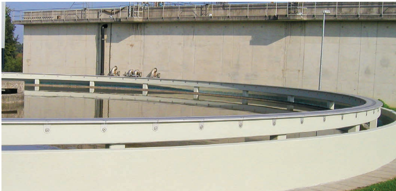
Räumlerfahrbahn auf einem Rundbecken-Neubau
