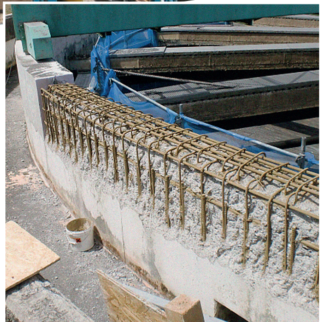
Korrosionsschutz der freigelegten Bewehrung und ...
