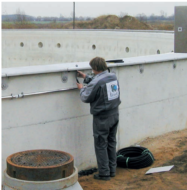
Elektroinstallation am Neubau
