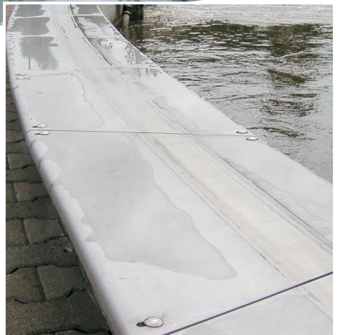
Das Räumerrad läuft störungsfrei dank Dachprofil
