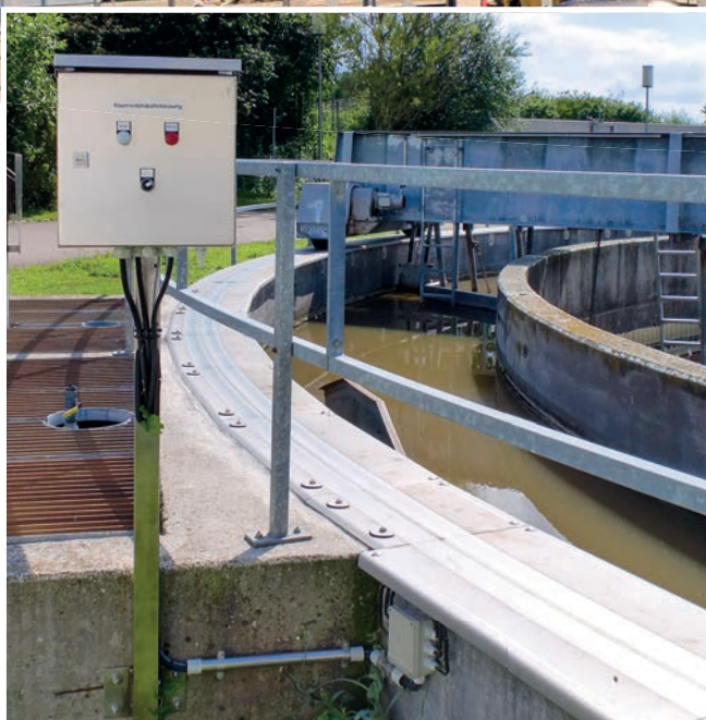
Rundbecken nach erfolgter Sanierung mit beheizter Räumlerfahrbahn
