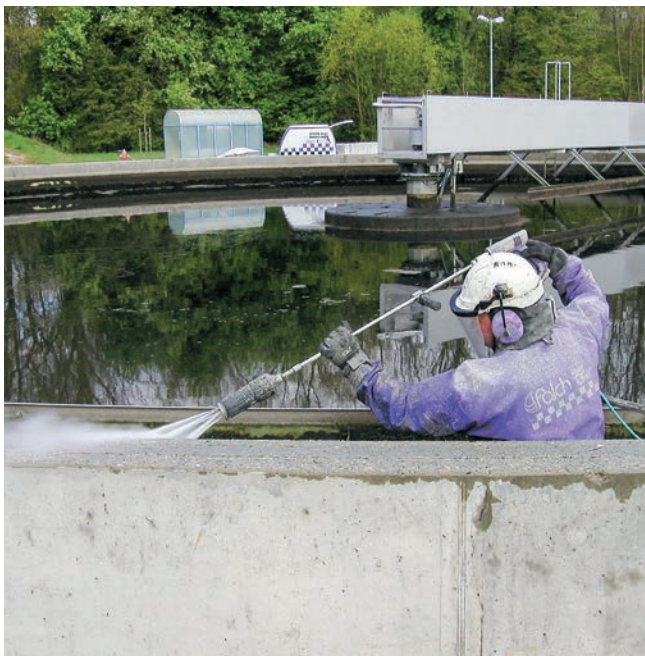
... Höchstdruckstrahlgerät mit 2.500 bar im Einsatz
