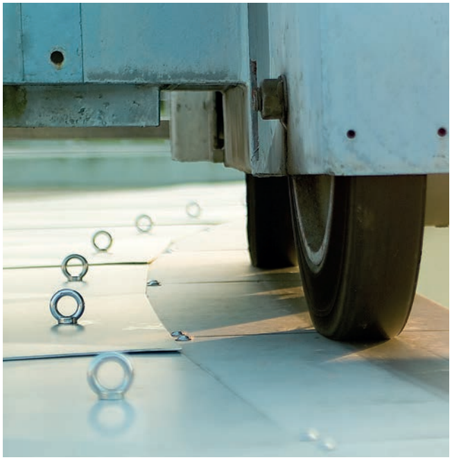
Höhengerechte Laufbahnen sorgen für minimalen Verschleiß der Räumertechnik
