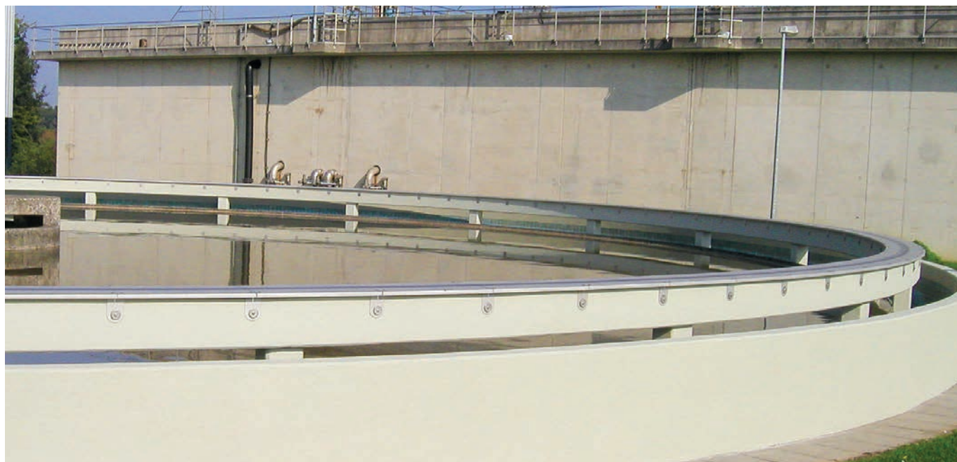
Via di corsa del carroponte su una vasca circolare di nuova costruzione
