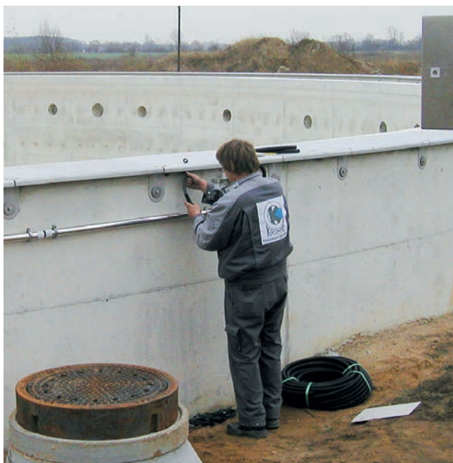
Installazione del sistema elettrico in una nuova costruzione
