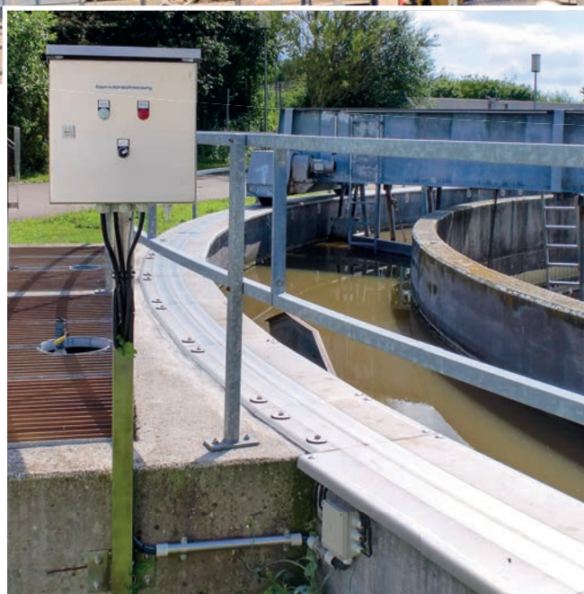
Vasca circolare dopo il risanamento con via di corsa del carroponte riscaldata
