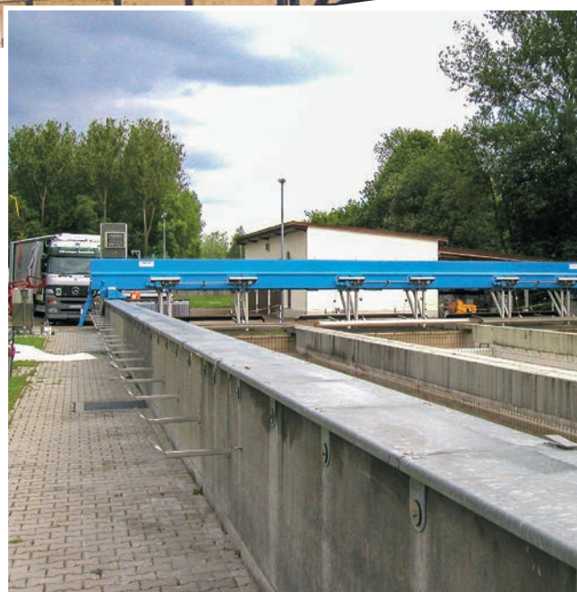
Via di corsa del carroponete su una vasca longitudinale
