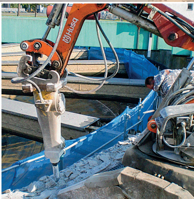
Robot demolitore e ...
