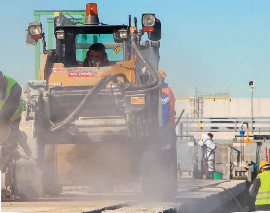
Rimozione del calcestruzzo tramite frese speciali
