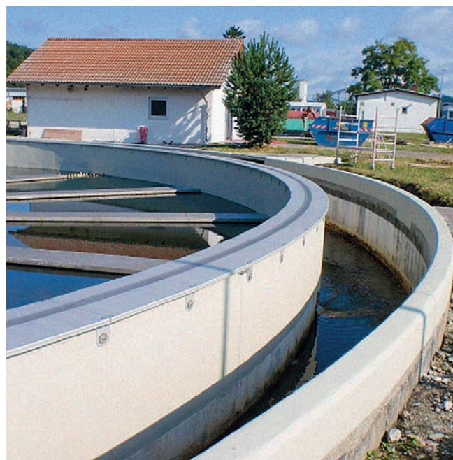
... il coronamento vasca dopo il risanamento
