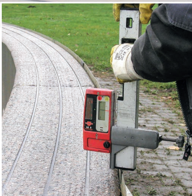
Vie di corsa perfettamente planari garantiscono una minima usura del carroponete
