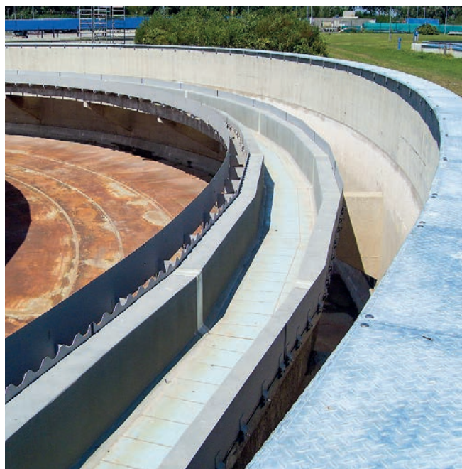
Profili a dente di lupo e lamiere di stramazzo in acciaio inox
