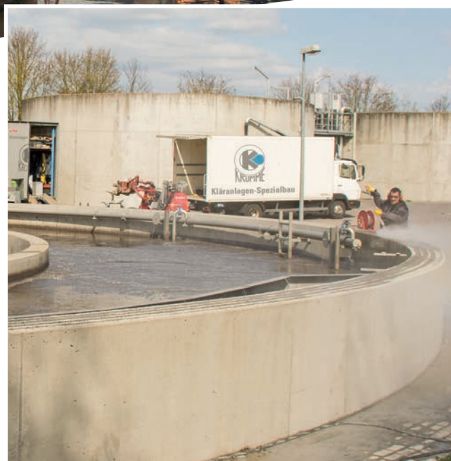
Le parti solide vengono asportate tramite getto ad altissima pressione verso l'esterno ...
